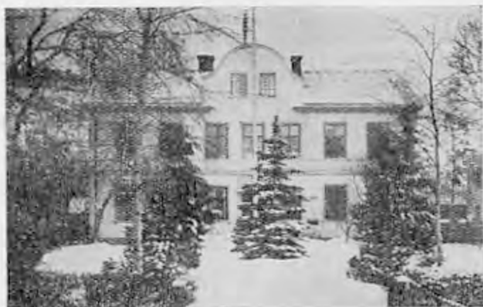
Exteriör av nuvarande post- och telegrafhuset.
